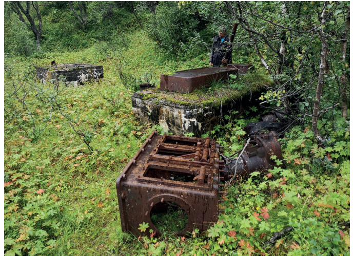
Kraftforsyning til linbanen.
