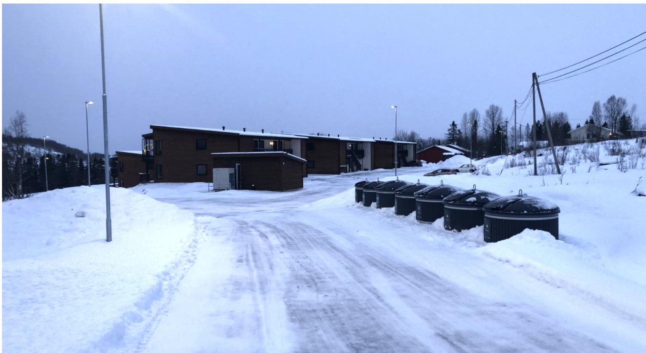
Utsyn mot vest, nytt bygg på gbnr 5/203 rett frem, bak til høyre eldre boliger 5/115 og 5/11, januar 2025. For de nye leilighetsbyggene er det etablert nedgravd renovasjonsordning.
