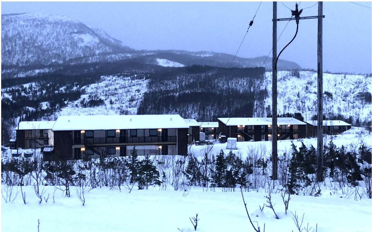
Sett fra Finnhaugveien ved Kraftstasjonen mot sør. Nye leilighetsbygg på gbnr 5/207- B10 nærmest, nedenfor leilighetsbygg på 5/208 – B6, 209 nederst bygg på 5/203 – B3.
