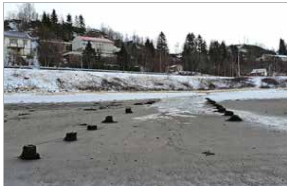
To av mange pålerekker i fjæra. Foto: Unn Kristin Laberg
