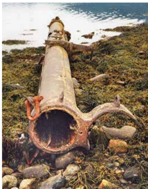
Stålmast i Østervikfjæra. Foto: Evenes bygdeboknemnd
