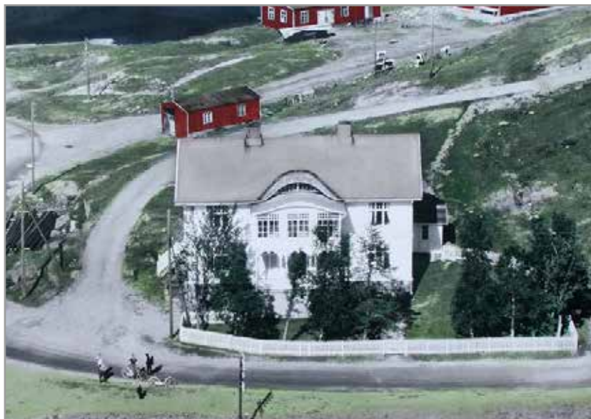
Administrasjonsbygget/gamle kommunehus (T2) i 1950-årene. Foto: Evenes kommune
