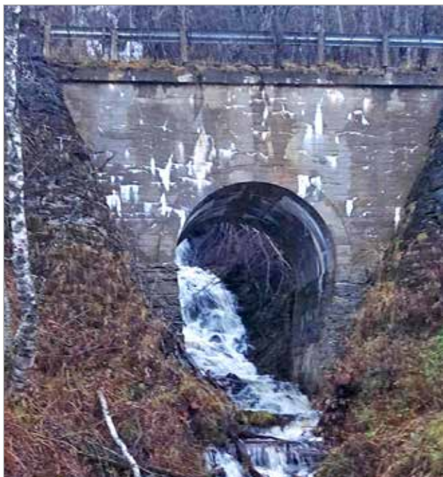
Over: Henrikbrua var en del av den gamle riksveien ved Jansbakken. Foto: Edna Nordanfjäll
