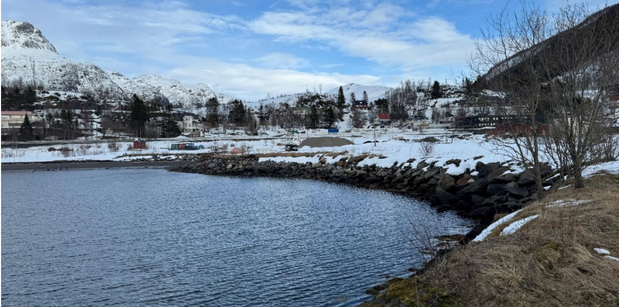
Figur 5: Viser er tatt omtrentlig ved eksisterende spunt og ser videre nordover
