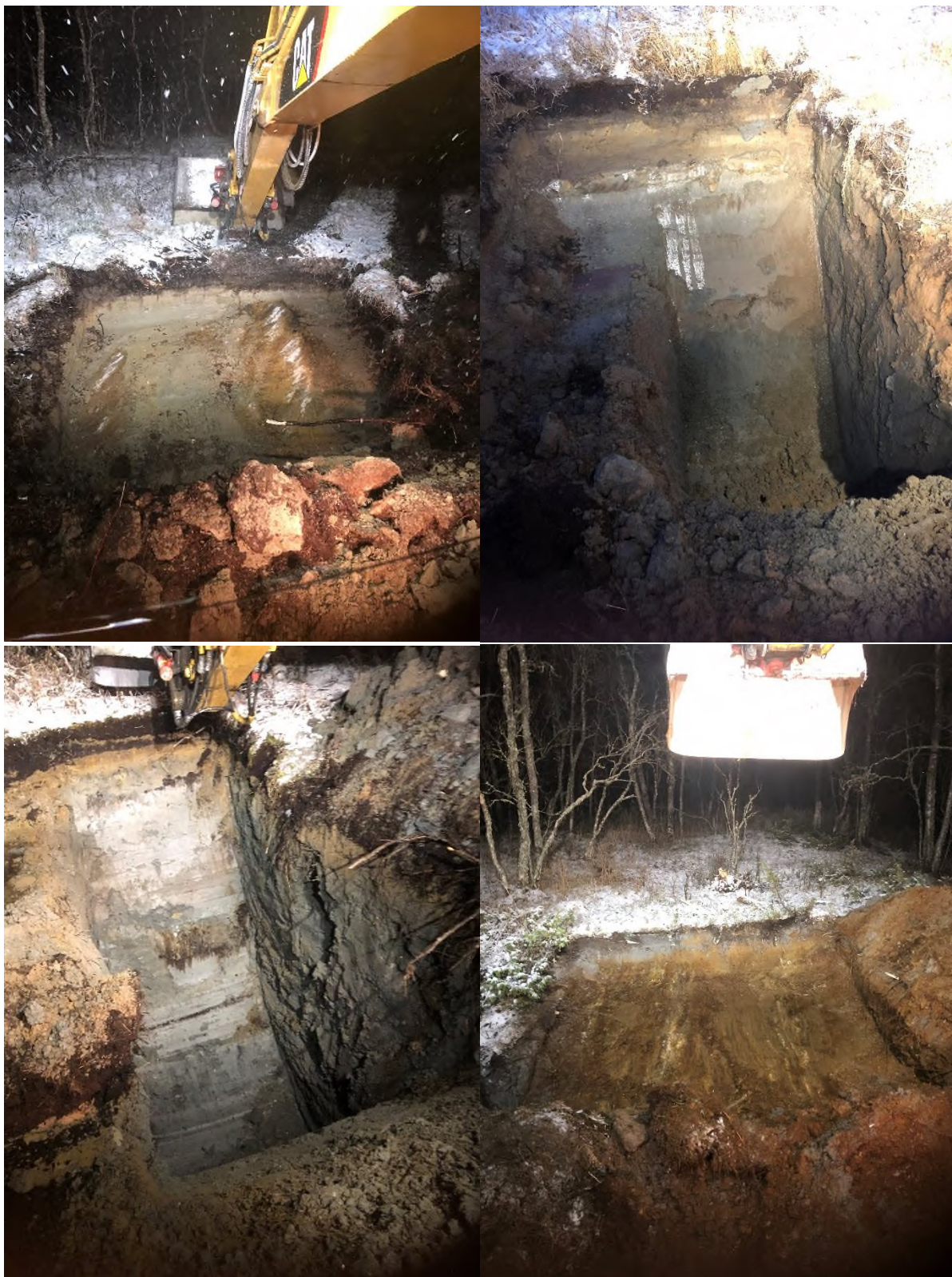
Figur 3: Bilder tatt av Harstad Maskin, Hull 9 (øverst til venstre), Hull 10 (øverst til høyre), Hull 11 (nederst til venstre), Hull 12 (nederst til høyre)
