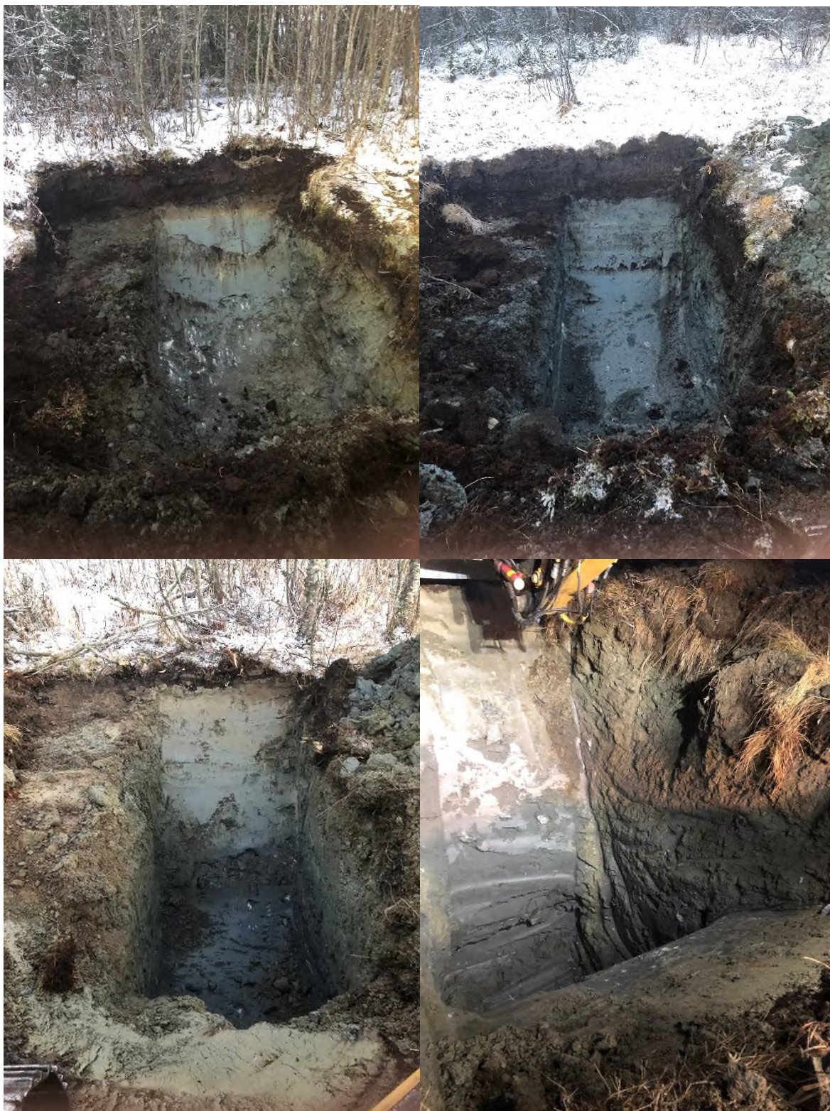
Figur 1: Bilder tatt av Harstad Maskin, Hull 1 (øverst til venstre), Hull 2 (øverst til høyre), Hull 3 (nederst til venstre), Hull 4 (nederst til høyre)
