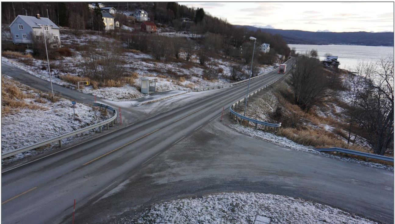
Figur 4-12. Bussholdeplass langs E10 for trafikk på tur inn til Bogen sentrum (Foto: Norconsult, november 2022).
