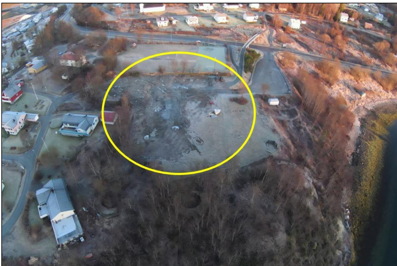
Figur 1-1. Tomt hvor Bogen skole stod oppført, fram til skolen ble revet høsten 2022 (Foto: Evenes kommune).
