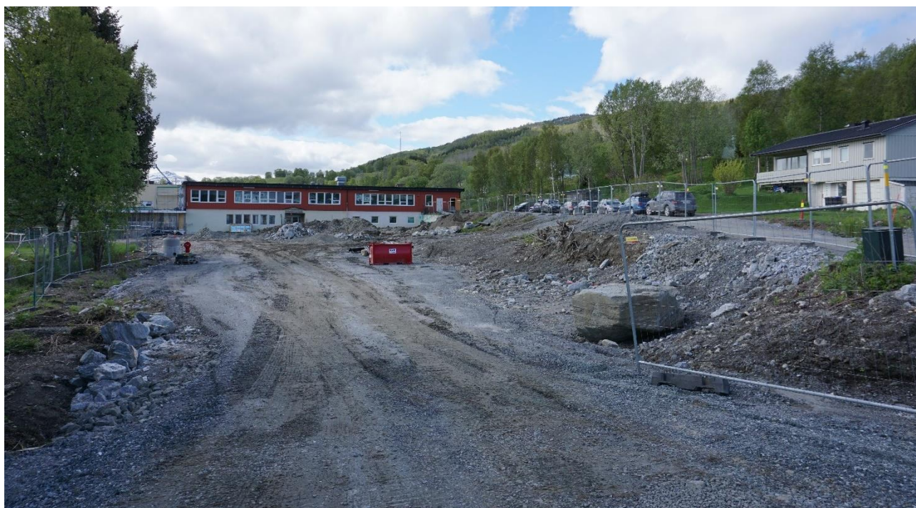
Figur 3-4. Adkomst til skolen fra Ostadbakken, nord på skoletomta. Foto: Norconsult 12.06.2020.
