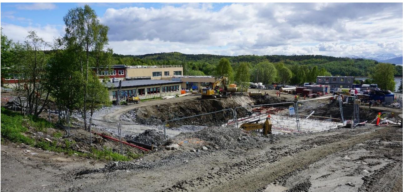
Figur 3-3. Ny flerbrukshall under utbygging sørøst på skoletomta. Foto: Norconsult 12.06.2020.
