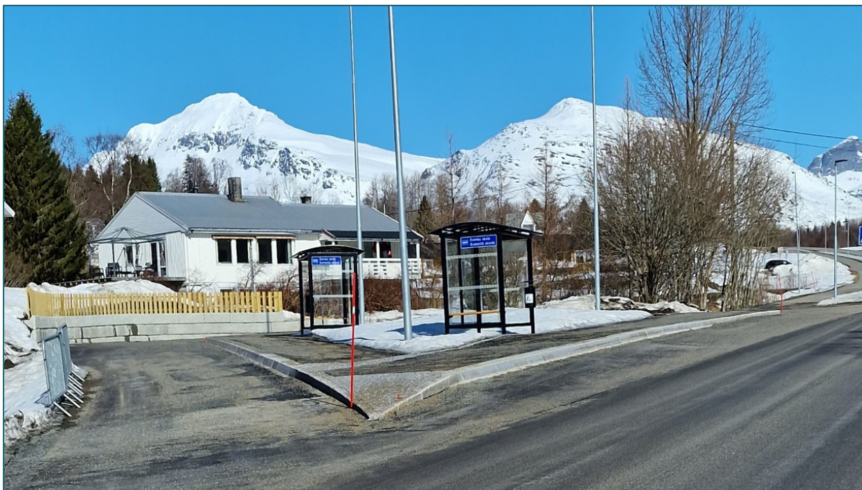
Figur 6: Busslomme for skolebuss sett fra Lilandsveien
